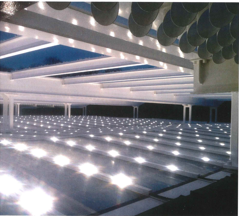
Het zonnedak in aanbouw, met de buisjes aan de onderzijde van de aluminium cassettes. De kliklijsten van het glasdak zijn voorzien van led-uplighters. (Foto: Gideon Goedhart)
